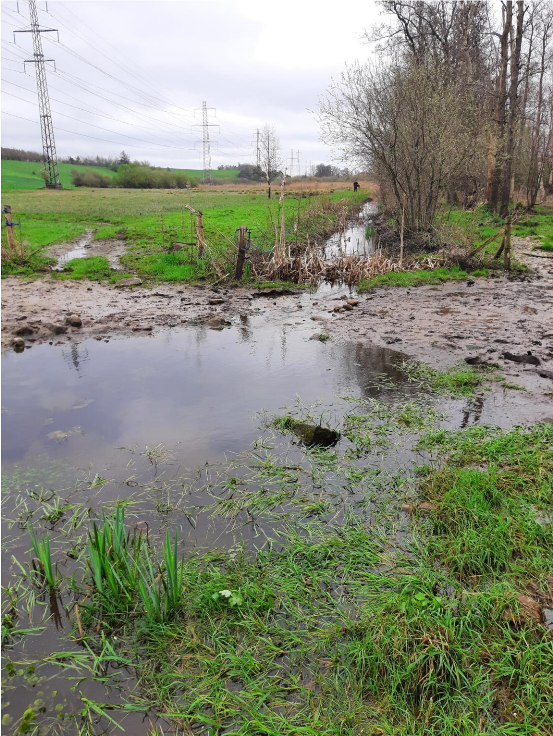
Figur 2 Station 512 Dette lignede en røverkørsel, men der fantes intet rør. Vand løber over terræn. Regulativet beskriver ingen bro her.
