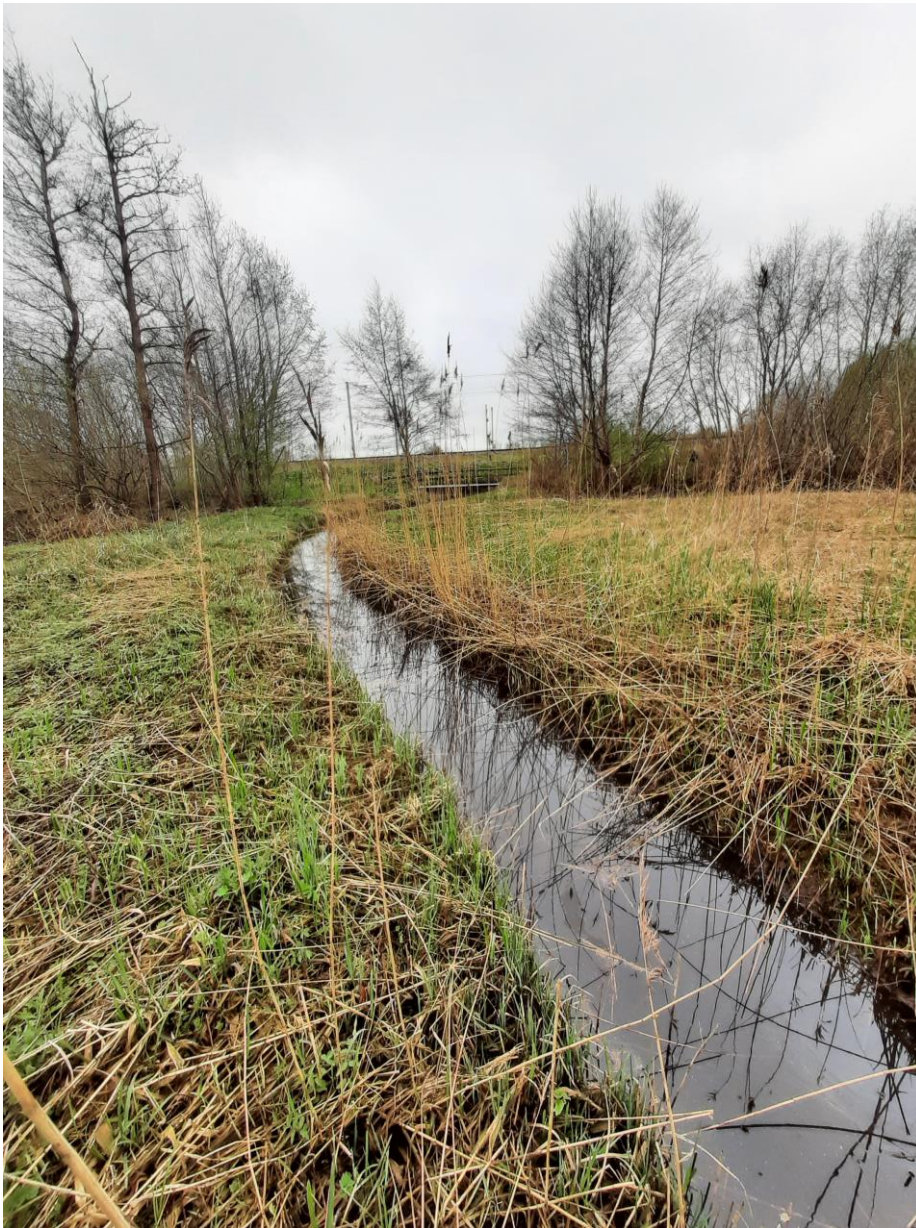
Figur 3 Station 1122 billede af ny strækning, med bro under jernbane.
